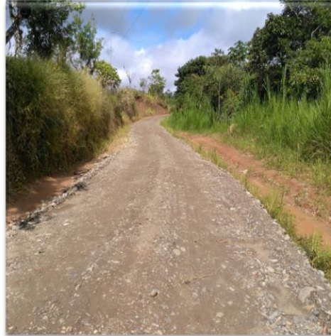
Mantenimiento camino cuesta La Chiva (6-08-268)
