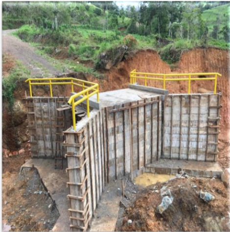
Construcción dos alcantarillas cuadro en Manta María (6-08-184)
