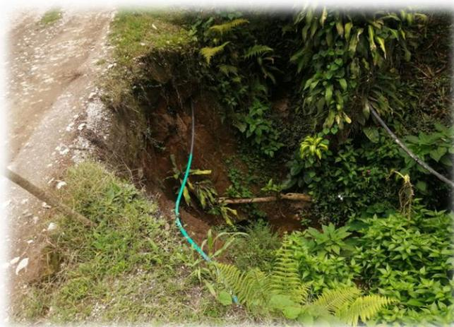
**Imagen 13. Socavación de calzada en paso de alcantarilla existente.**
