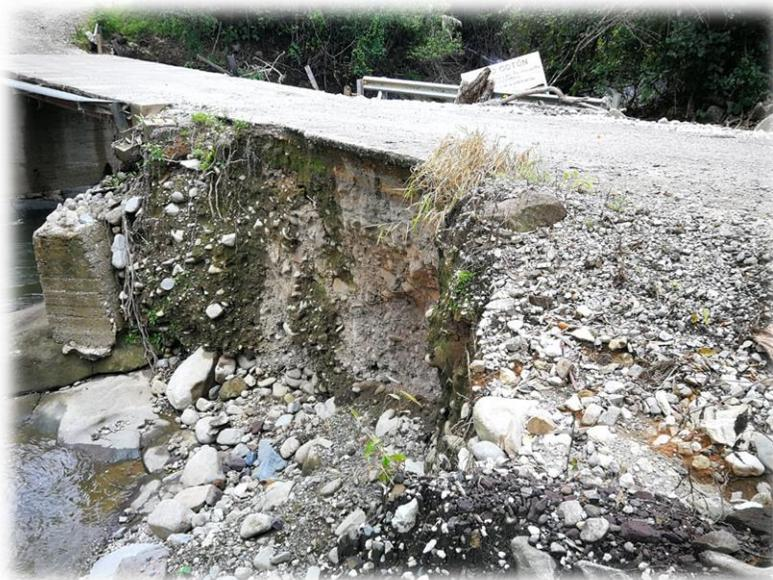
**Imagen 2. Socavación de la calzada en aproximación al Puente sobre Río Cotón.**
