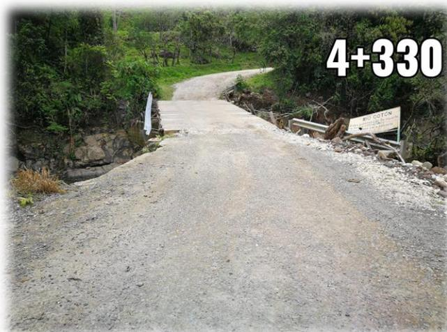
**Imagen 3. Barandas de Puente sobre Río Cotón en mal estado.**
