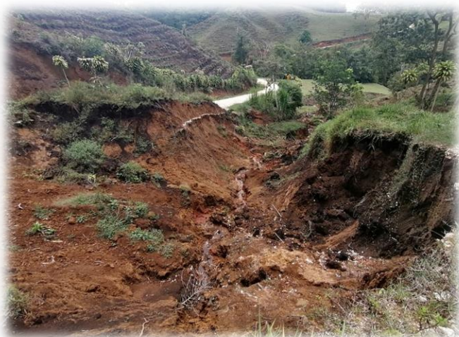
Imagen 14. Hundimiento Camino Valle Azul – San Martín 6-08-325.
