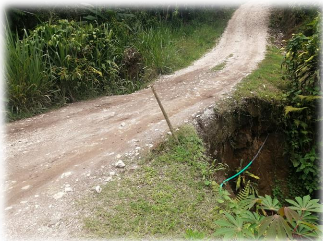
Imagen 12. Estado actual de la vía ancho de 3.00m.
